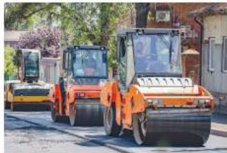
Асфальтирование дорог Ростова
