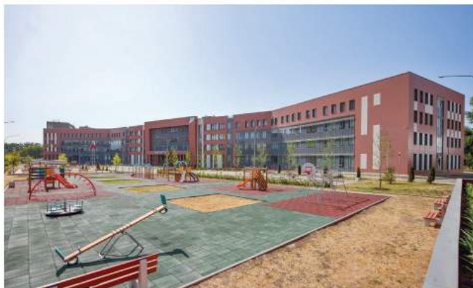
Новая школа в микрорайоне ЮФУ
