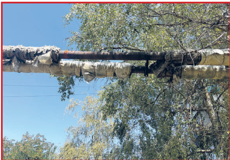
Трубы отопления по ул. Майской, 32. Интересно, дойдёт ли зимой до квартир жильцов хоть немного тепла, прежде чем потерявшие изоляцию трубы разорвёт?
