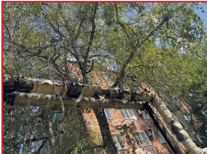
Трубы отопления по ул. Майской, 32. Интересно, дойдёт ли зимой до квартир жильцов хоть немного тепла, прежде чем потерявшие изоляцию трубы разорвёт?
