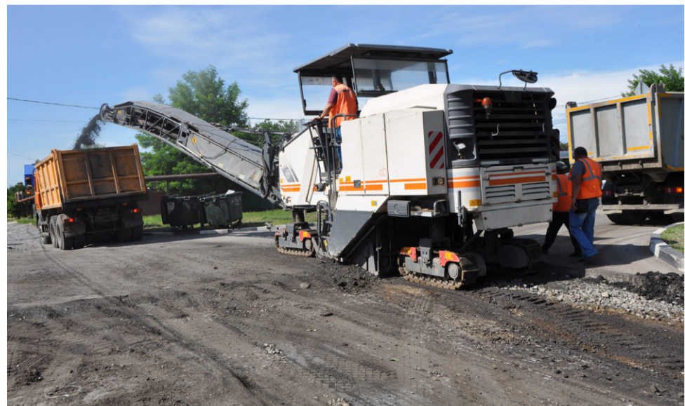
Капитальный ремонт автомобильной дороги в городе Азове
