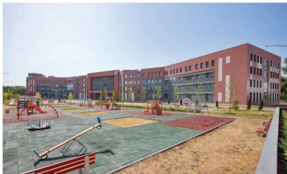
Новая школа в микрорайоне ЮФУ
