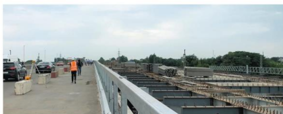
Строительные работы идут полным ходом
