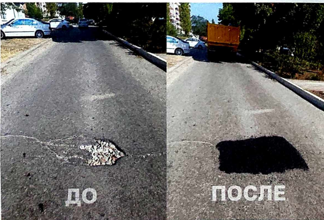
Ямочный ремонт дороги от улицы Инзенской до улицы Севастопольской.
