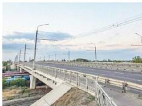
Мост на Малиновского
