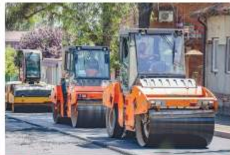
Асфальтирование дорог Ростова
