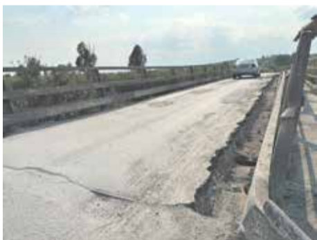
Мост в х. Яново-Грушевский отремонтируют уже в августе
