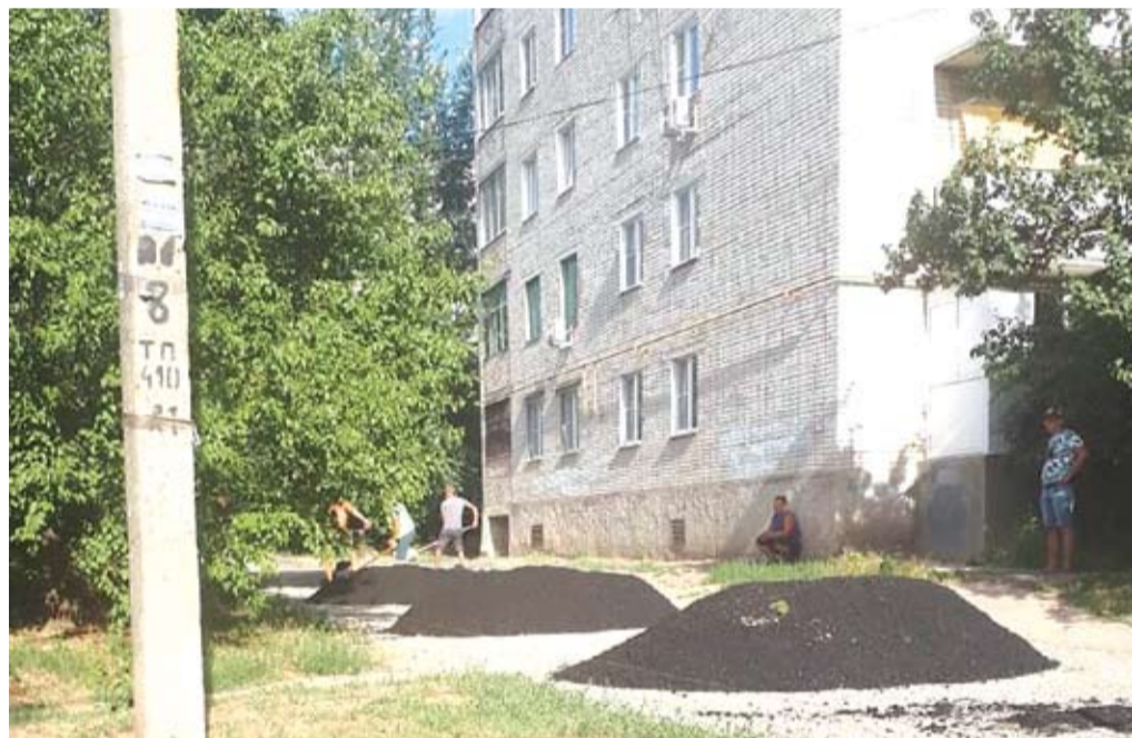
В рамках думской программы по асфальтированию внутриквартальных дорог Александру Алфимову и Евгению Белакову удалось отремонтировать более 2 000 квадратных метров асфальтового покрытия. Эта работа должна продолжаться и дальше.
