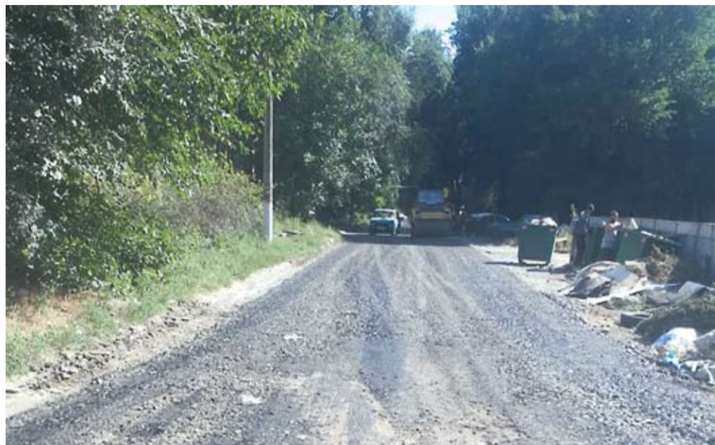
Дороги в частном секторе необходимо регулярно подсыпать щебнем и грейдировать.
