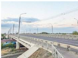
Мост на Малиновского
