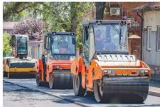
Асфальтирование дорог Ростова
