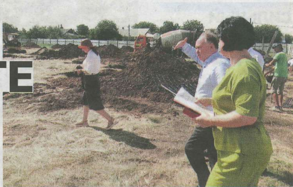
Андрей Харченко проконтролировал ход строительных работ.
