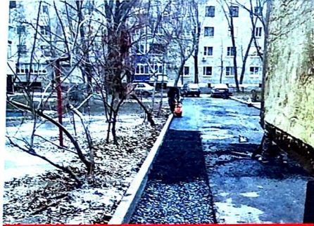
В 2020 году Командой были организованы работы по расширению проезжей части, чтобы обеспечить удобный проезд для машин скорой помощи, ул. Кондаурова, 57.
