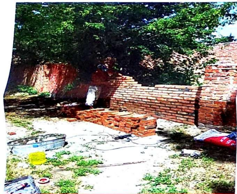
Восстановление кирпичного забора, ул. Кондаурова, 63.
