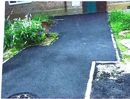
Восстановление асфальтового покрытия после текущего ремонта тепловой трассы, ул. Кондаурова, 65.
