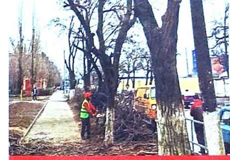
Опиловка аварийных деревьев, ул. Кондаурова, 2021 г.
