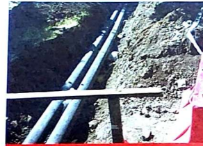
Капитальный ремонт теплотрассы, ул. Кондаурова, 2017 г.
