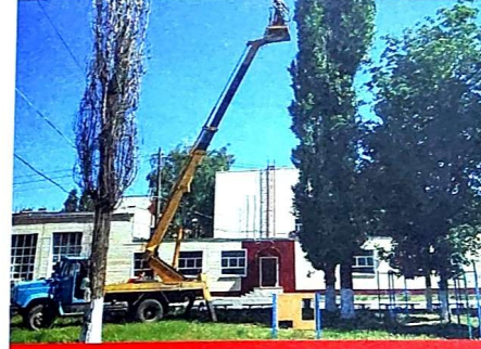
Опиловка аварийных деревьев во дворе школы № 13. Безопасность детей – наш приоритет.
