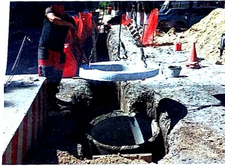
Капитальный ремонт канализационной сети при поддержке Губернатора Ростовской области, ул. Кондаурова, 63, 65, 67, 69.
