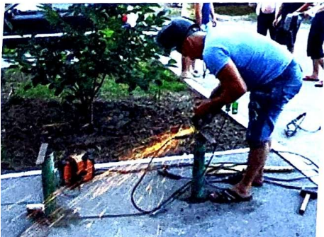
Установка лавочек у подъездов жилых домов, пер. Осипенко, 47, ул. Комсомольская, 68.
